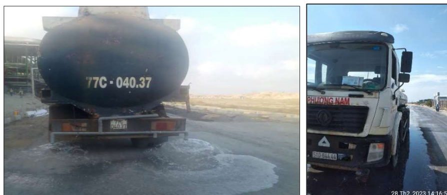
Hình 16. Hoạt động tưới nước tuyến đường di chuyển
