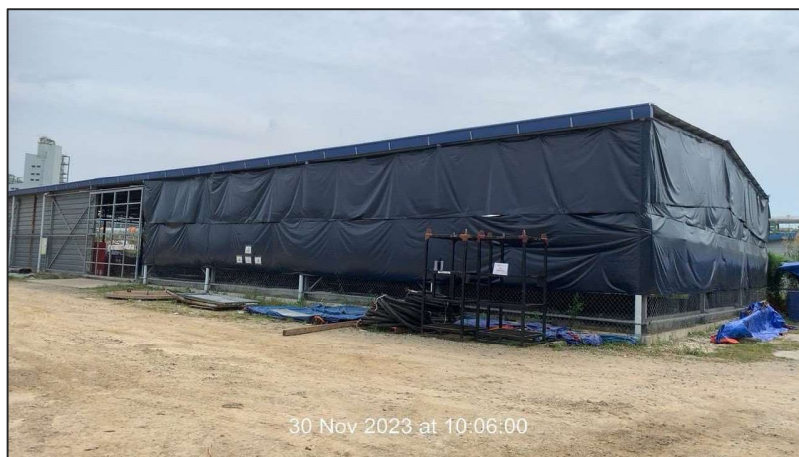
Hình 22. Khu vực lưu trữ chất thải nguy hại tạm thời tại gói thầu A1
