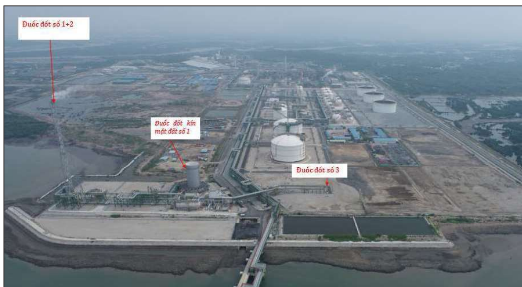
Hình 14. Vị trí của hệ thống các đuốc đốt
