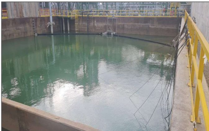
Hình 3. Bể chứa nước thử thủy lực và làm sạch đường ống PIT 5615
