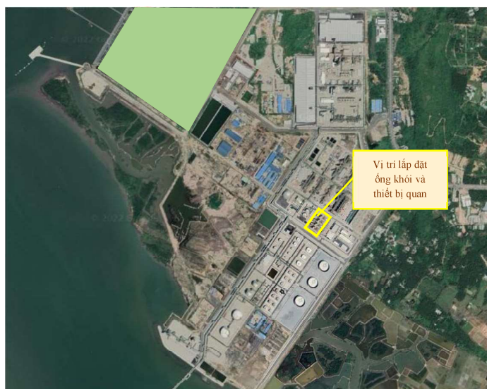
Hình 17: Vị trí lắp đặt hệ thống quan trắc khí thải tự động
